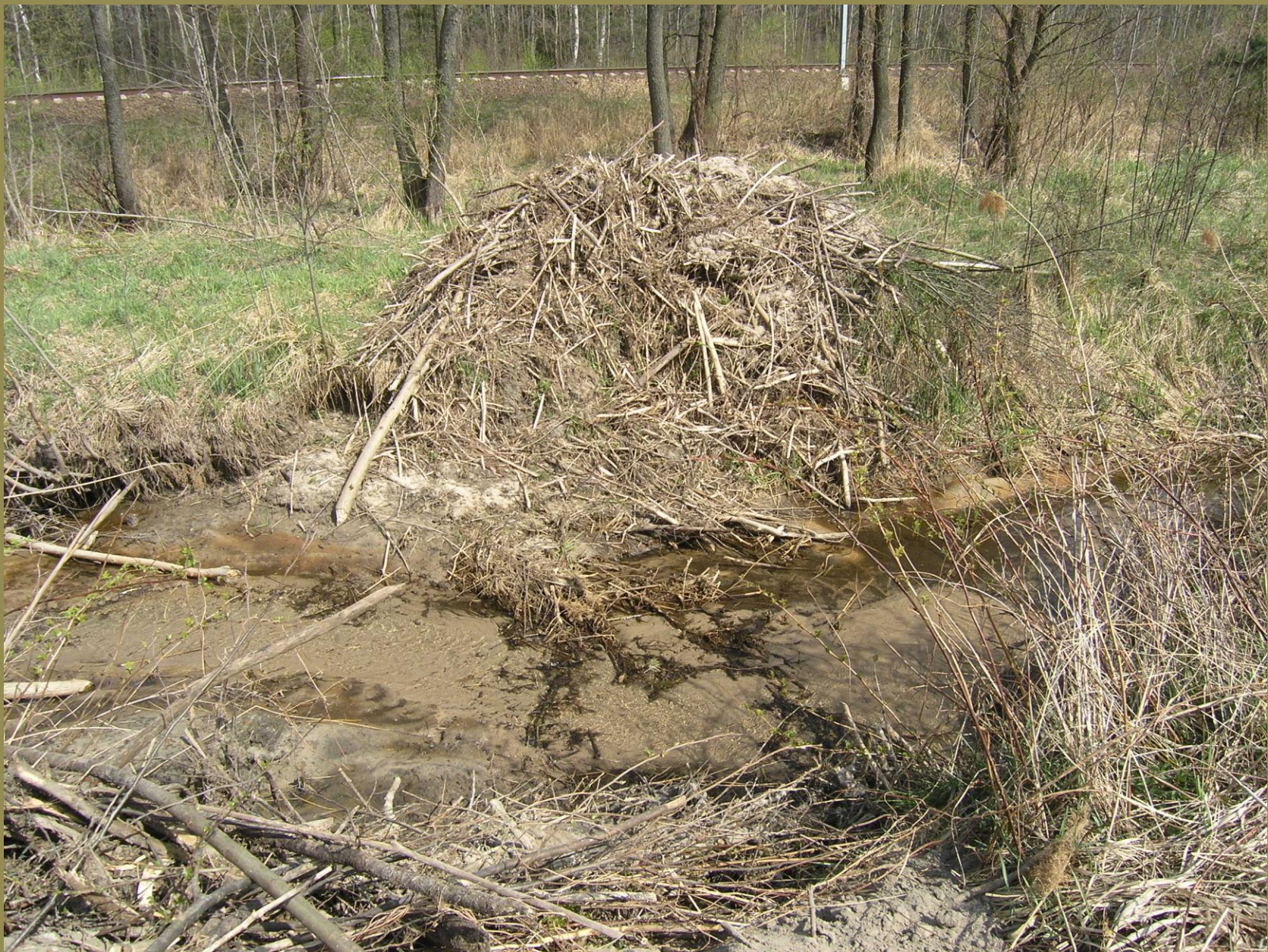
Pozostałości po rozebranej tamie - stawy rybne w Irządzach
