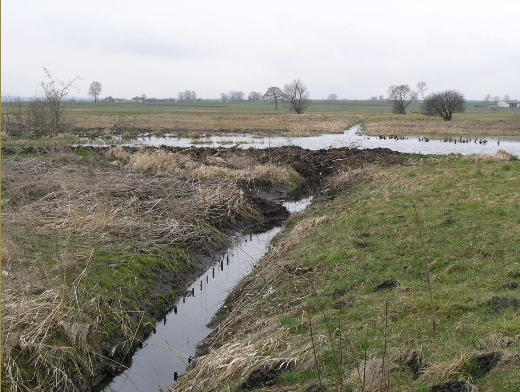
Rozlewiska powstałe wskutek zablokowania rowu melioracyjnego Otola gm. Żarnowiec
